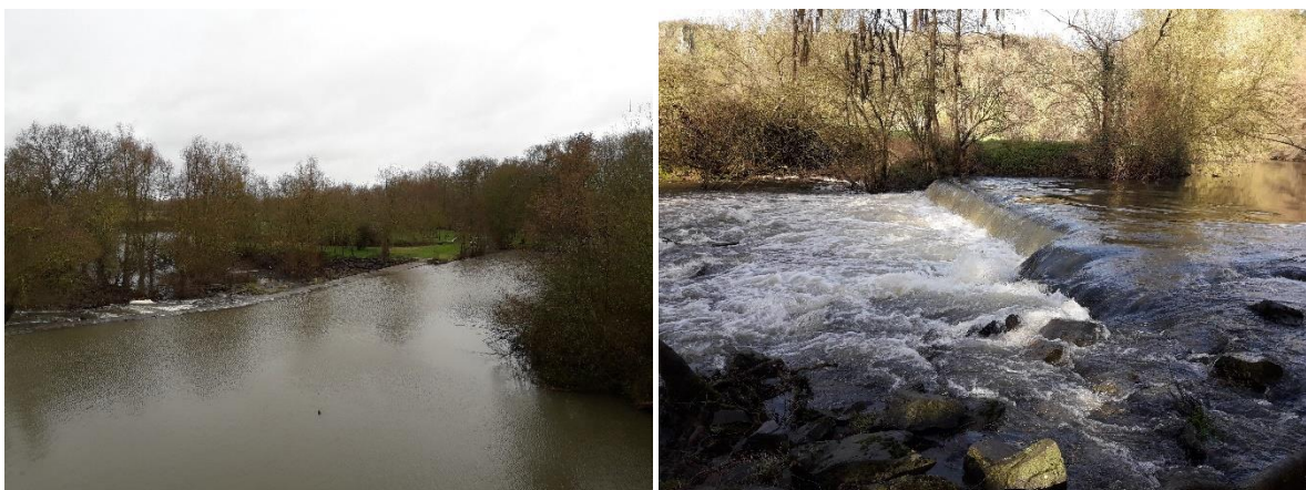
Figure 142 : Situations dégradée – Source : Hardy Environnement
